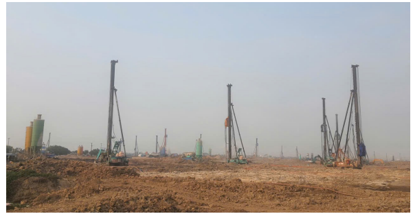
Công trường thi công Cảng hàng không quốc tế Gia Bình
